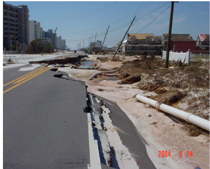
Perdido Key Drive
